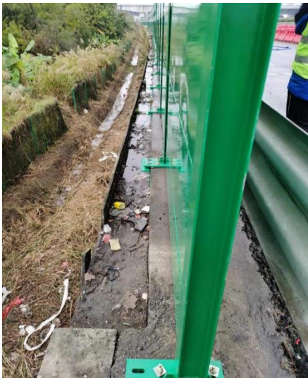
(a) 护壁与路面之间的水槽
