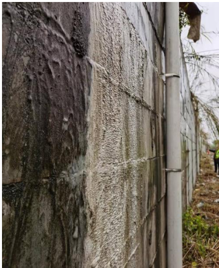
(b) 护壁外侧析出的CaCO 3
