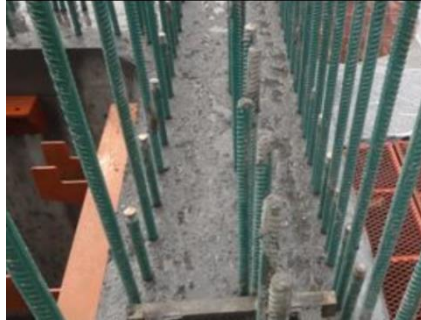
图 12 施工缝浸水养护
