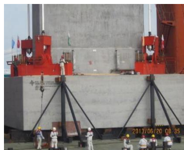
图36 墩台吊装示意图
