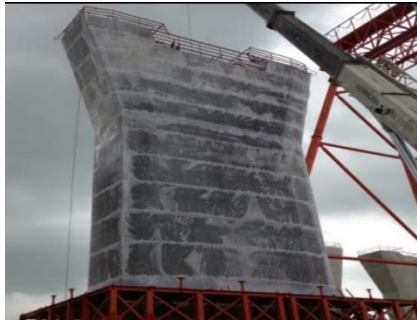
图 11 塑料膜包裹养护
