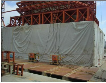
图 9 承台围裹土工膜养护
