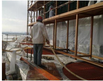
图 10 覆盖塑料布洒水养护
